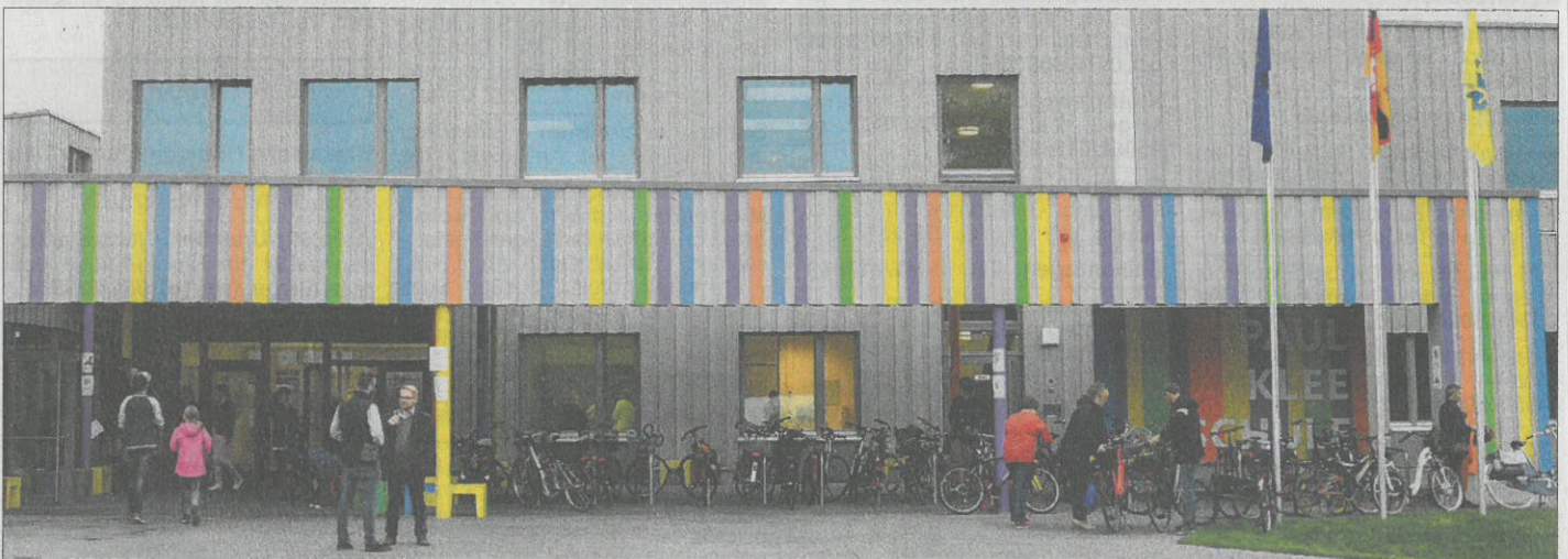
Mehr als 140 Schüler - für diese Zahl war der Neubau ausgerichtet - besuchen jetzt die Paul-Klee-Schule in Celle (Foto), sodass eine Außenstelle in Bergen geplant ist. Archivfoto: Müller
